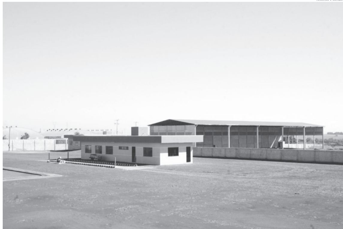
Em ritmo acelerado, as empresas estão sendo instaladas no setor industrial
